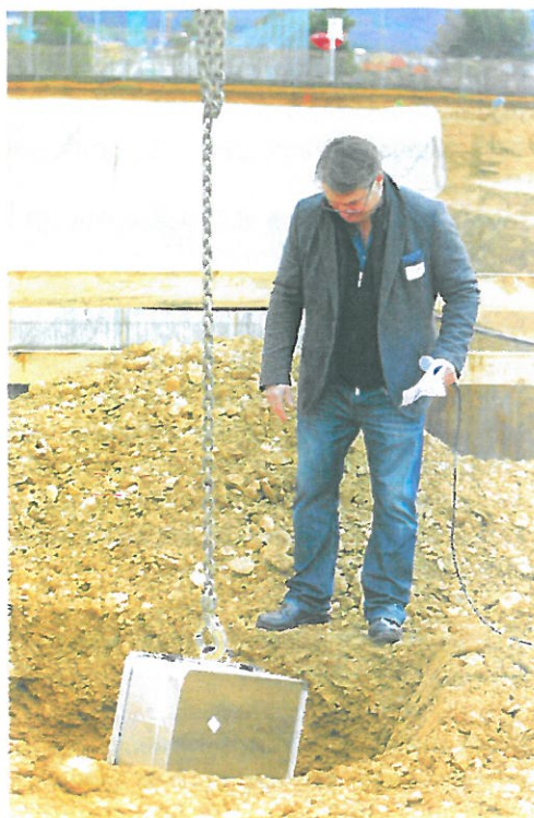
Präzise versenkt ein Kranführer den Metallkoffer in der vorgesehenen Erdgrube.
